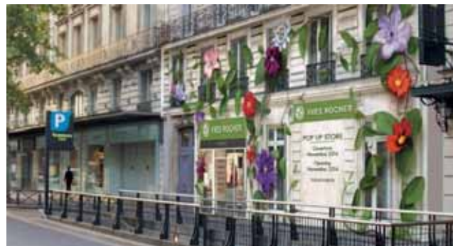
Espace en travaux
