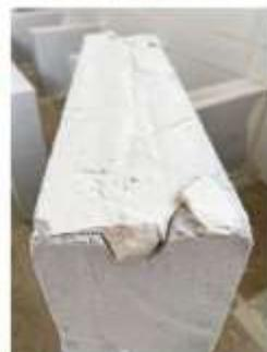
10 Le cas échéant, remplacez entièrement la rainure d'assemblage en même temps que la tranche du caisson.
