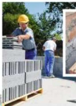
4 Les blocs de pierre ponce sont garantis 100 % durables et recyclables. Fabriqués sans cuisson, ils nécessitent moins d'énergie que les matériaux subissant un traitement thermique. N'est-ce pas ce qui le transporte (par voie maritime) jusqu'au site de transformation française implique en termes de bilan carbone.
