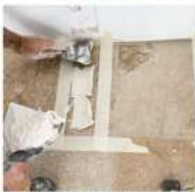
9 Préparez la coiffe et déposez-la en couche épaisse sur le sol, le mur et les faces de contact de chaque jambage. Ce double encollage permet à la fois de renforcer l'adhérence et de compenser d'éventuels défauts de planéité du support.
