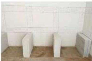
7 Procédez à un montage à blanc des jambages pour vérifier que les tracés sont bien de niveau et d'aplomb. Faites les corrections qui s'imposent et ôtez-les.
