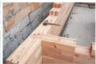
5 Facile à monter, le parpaing en bois massif tire profit des propriétés isolantes de sa matière première. Un complément d'ITE est néanmoins requis pour une construction conforme à la RE 2020.
