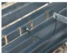
**17** Pour faciliter le réglage d'inclinaison, nouez un corde réglable au bout du bras articulé et à l'autre extrémité à un crochet vissé sous le barreau encoché.
