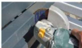
**16** Les encoches doivent être un tout petit peu plus larges que l'épaisseur du bras articulé. Réalisez les entailles sur 5 mm de profondeur environ à l'aide d'une meuleuse d'angle ou d'un outil multifonction équipé d'une lame adaptée.
